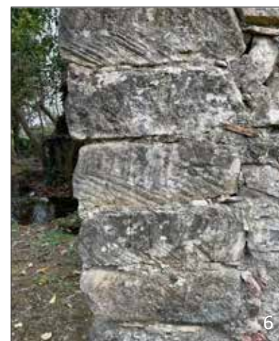
Figura 1. La gorgata del Prato Comune Figura 2. La Fucina e la Macina (ora Camping Molino) con il canale e le due gorgate Figura 3. La canalizzazione artificiale Figura 4. Il canale posto sulle arcate sopraelevate Figura 5. Le vasche di raccolta dell'acqua a valle delle arcate. Figura 6. Conci di pietra tenera tagliati con piccozzina.
